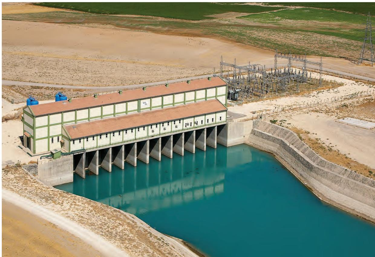
Проектом предусмотрена ирригация территории площадью 8 669 гектаров с помощью систем капельного и спринклерного орошения водой, подающейся под давлением из плотины им. Ататюрка. В рамках проекта сооружены 4 насосные станции для забора воды из водохранилища плотины им. Ататюрка, стальной трубопровод, резервуар, главный канал, фильтрационные станции, ирригационная система из труб различного диаметра с подачей воды под давлением.
