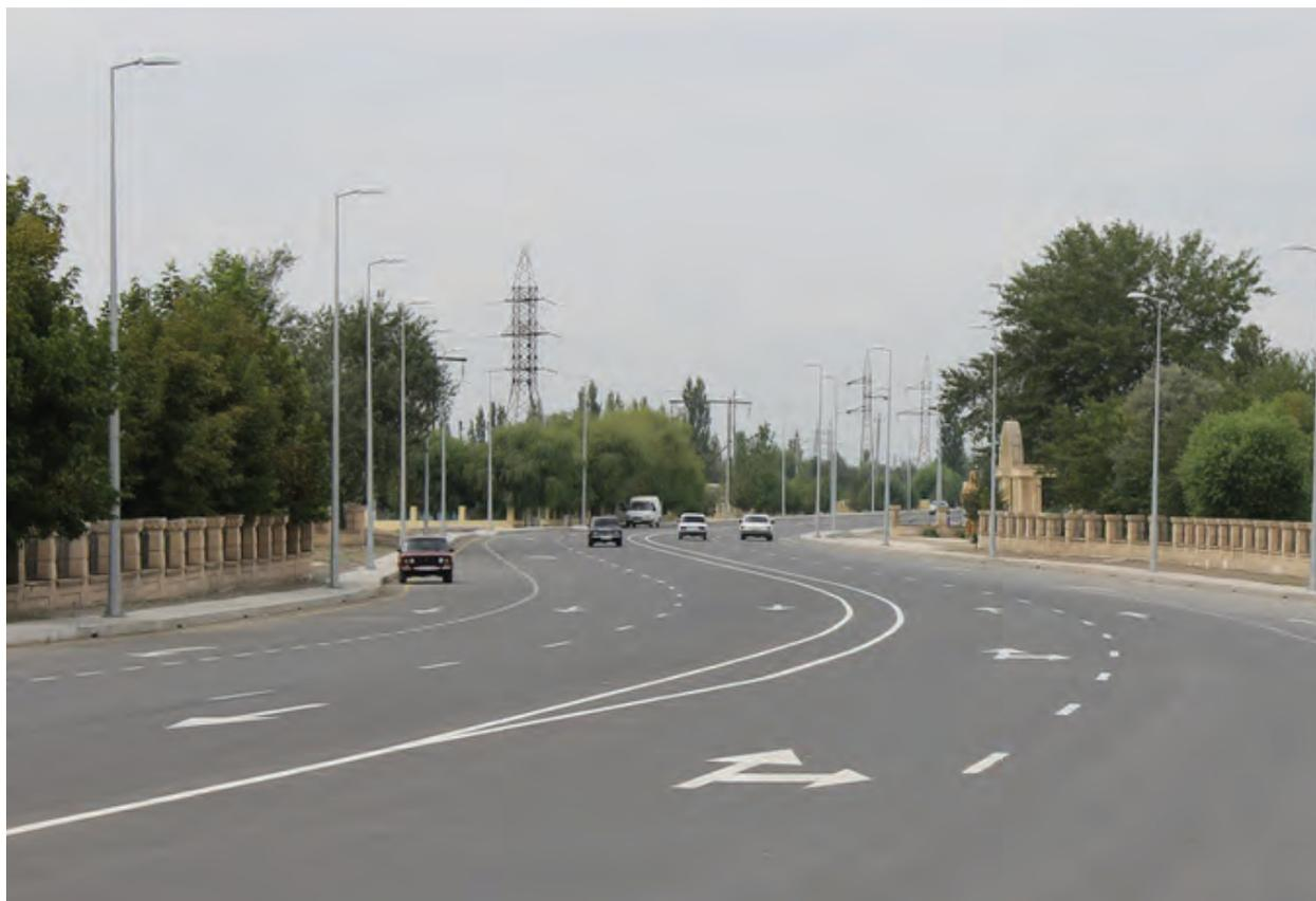
Второй лот проекта восстановления автотрассы М6 Аджикабул-Горадиз включает в себя работы по строительству 2-полосной автомобильной трассы общей протяженностью 72,05 км. Кроме того, в рамках проекта устроены каналы для непрерывного отвода воды, подъездные дороги, дорожная разметка, дорожные ограждения, установлены новые светофоры и дорожные знаки.
