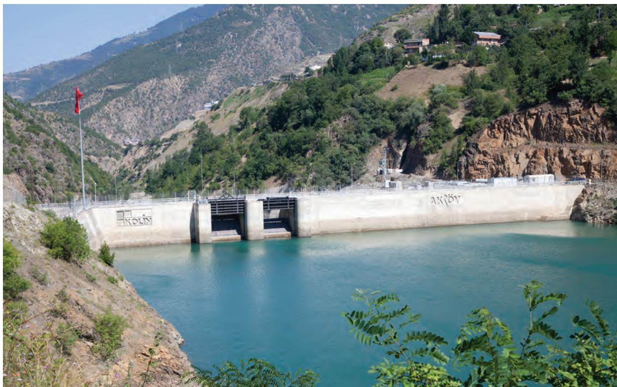
Среднегодовая производительность I Аккёйской плотины и ГЭС в провинции Гюмюшхане составляет 320 гВт/г. Энергия вырабатывается путем передачи воды из реки Харшит через энергетический туннель длиной 12,430 м, расположенный в низовье Кюртюнской плотины, а также падением потока с корпуса плотины с проходом через напорный туннель.
