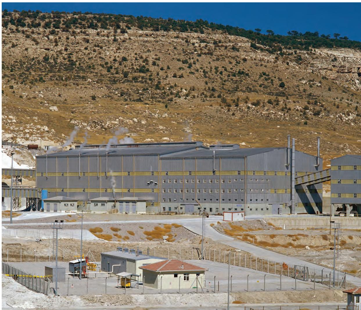
По запасам бора Турция занимает первое место в мире. С 1983 года предприятие АО «ЭТИ Холдинг» производит продукты переработки бора. В дополнение к двум ранее построенным и функционирующим заводам по переработке бора компанией «Колин Иншаат» построен третий завод. Завод сдан «под ключ» после завершения всех работ по проектированию, строительству, поставке и монтажу механизмов и оборудования, установки всех систем автоматизации.
