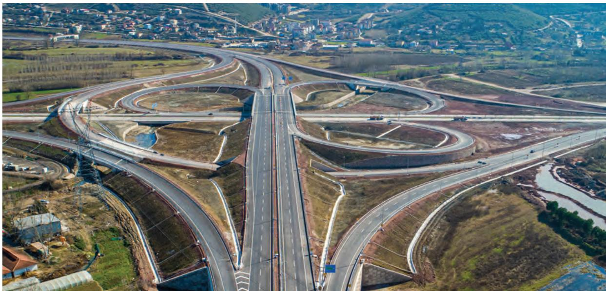
В рамках проекта строительства Северомраморноморской автотрассы Kuzey Marmara Otoyolu (в т.ч. 3-й Босфорский мост), участок Курткёй-Акъязы, между 5-м отрезком на отм. 187+730-193+500 и 6-м отрезком на отм. 193+500-232+900 компанией «Колин Иншаат» выполнены следующие работы: строительство автомагистрали с полосностью 2x4 протяженностью 45 170 м, 5 основных развязок, 6 развязок с подъездными дорогами, 2 туннелей и 8 виадуков.
