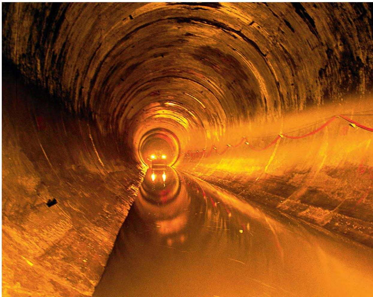
В ходе работ по проекту, расположенному между плотиной им. Ататюрка и главным каналом долины Харран, выполнено два туннеля протяженностью 26 км каждый с железобетонным покрытием, выполнены усилительные и инъекционные работы, а также нанесение бетонного покрытия.
