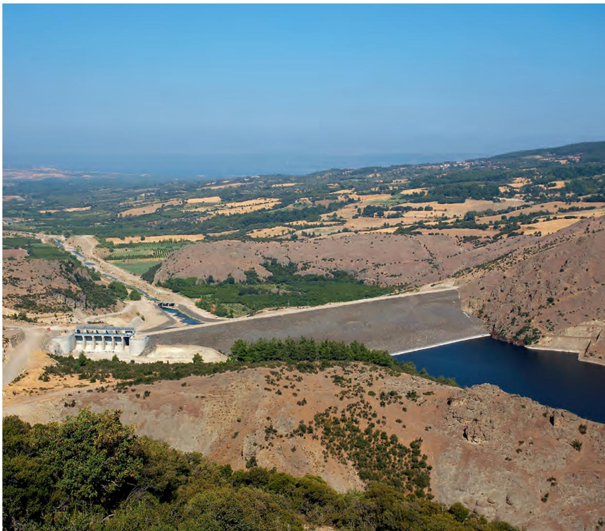
Проект по орошению участка площадью 3 661 га в долинах Ляпсеки и Умурбей предусматривает строительство плотины с глиняной диафрагмой, гребнем длиной 458 м и высотой 81 м от основания. В рамках проекта выполнен бетонный отводной туннель подковообразной формы, шлюз радиальной формы, трубопровод с дроссельным клапаном и коническим вентиляем для регуляции давления.
