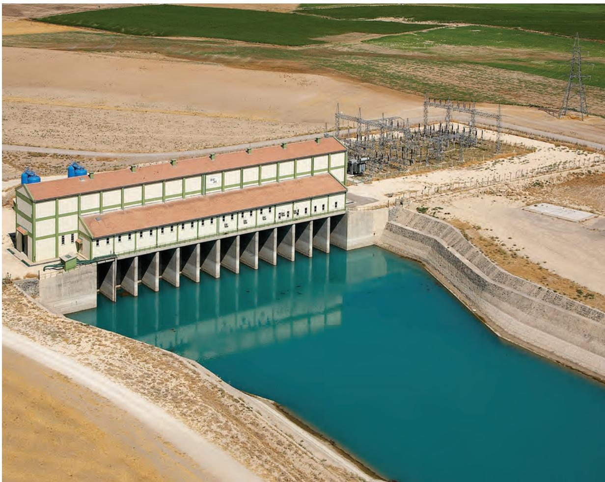
Atatürk Barajı'ndan pompaj ile temin edilen suyun basınçlı yağmurlama ve damlama sulama sistemleri ile toplam 8.669 hektarlık alanın düzenli olarak sulanmasını sağlayan proje kapsamında; ikisi Atatürk Barajı Gölünden olmak üzere 4 adet pompa istasyonu, çelik cebri boru, rezervuar, ana kanal, filtre istasyonları, muhtelif çaplarda boru ile basınçlı bir sulama şebekesi inşa edilmiştir.
