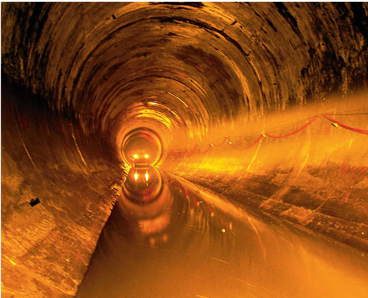
Atatürk Barajı ile Harran Ovası Ana Kanalı arasında her biri 26 km uzunluğunda iki adet betonarme kaplama tünel, bu tünelerin ekseni boyunca bağlantı tünelleri ve ulaşım tünellerinin desteklenmesi, enjeksiyon işleri ve beton kaplama yapımı gerçekleştirilmiştir.
