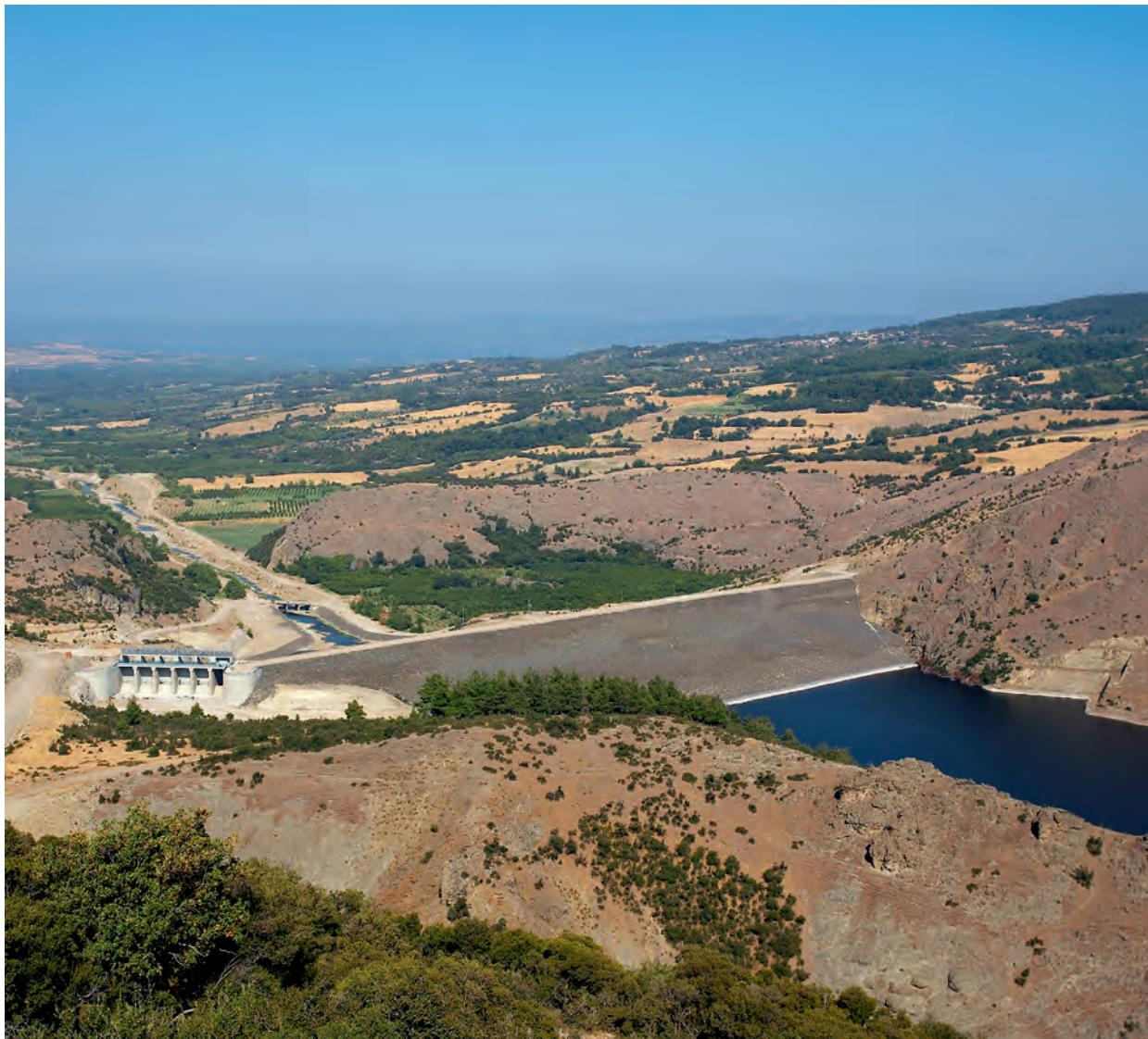
Lapseki ve Umurbey ovalarındaki 3.661 hektar arazinin sulanmasını amaçlayan, temelden yüksekliği 81,00 m ve kret uzunluğu 458 m olan kil çekirdekli kaya dolgu bir barajın yapımını öngören proje kapsamında at nalı kesitli beton kaplama derivasyon tüneli, radyal kesitli dolusavak, cebri boru ile kelebek ve basınç kırıcı konik vana kullanılmıştır.
