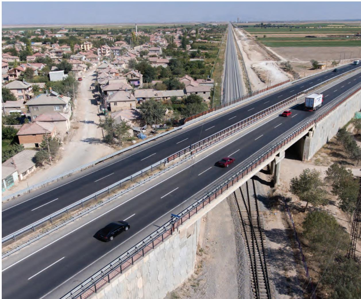
Konya ile Karaman istasyonları arasında, çift hatlı hızlı tren standartlarına uygun olacak şekilde, tek hattın rehabilite edilmesi ve yanına yeni bir hat eklenerek çift hatta dönüştürülmesi için, 98 km çift hat olacak şekilde; zemin iyileştirme, toprak işleri, menfez işleri, hat üzerindeki hemzemin geçitler yerine alt ve üstgeçitler yapılması için, demiryolu köprüsü, 196 km demiryolu hattının balast, ray, travers serilmesi işleri, makas temini ve montajı işlerinin yapımını kapsamaktadır.
